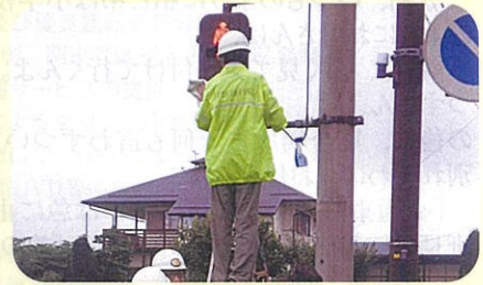
管内に設置された歩行者用信号機、コープミラー等の点検・清掃を実施した。 (池田松川)
