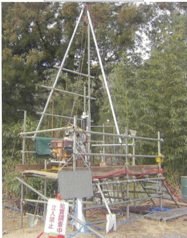
例. ボーリング作業の様子
