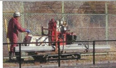
例. クローラーによる資機材運搬の様子
