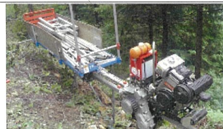
例. モノレールによる資機材運搬の様子
